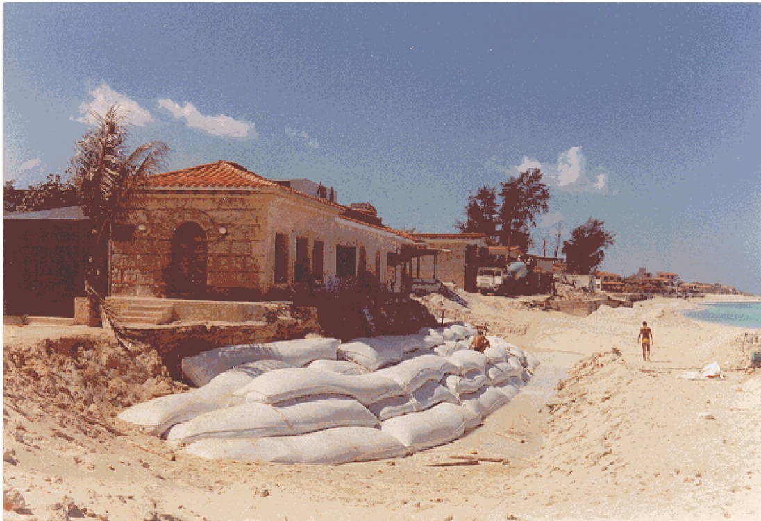
Foto 1. Vista de la estructura del Brocal.
