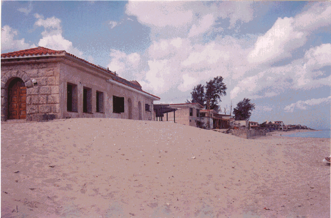
Foto 2. Duna artificial conformada sobre la estructura.
